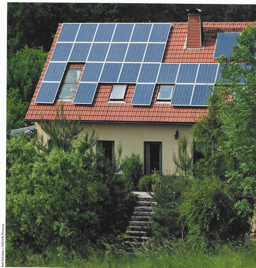
Bestandsproblem? Diese 2011 in Betrieb genommene Anlage (in Königshain, Sachsen) würde heute, im Alter von zehn Jahren, kaum eine neue Versicherung bekommen
