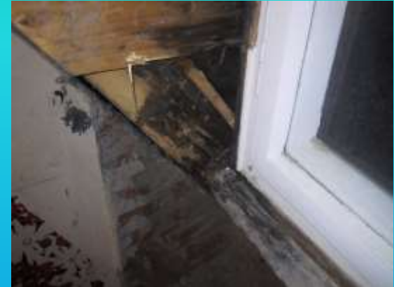
Westgaube mit Feuchteschäden
