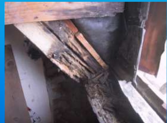
Westgaube mit Feuchteschäden
